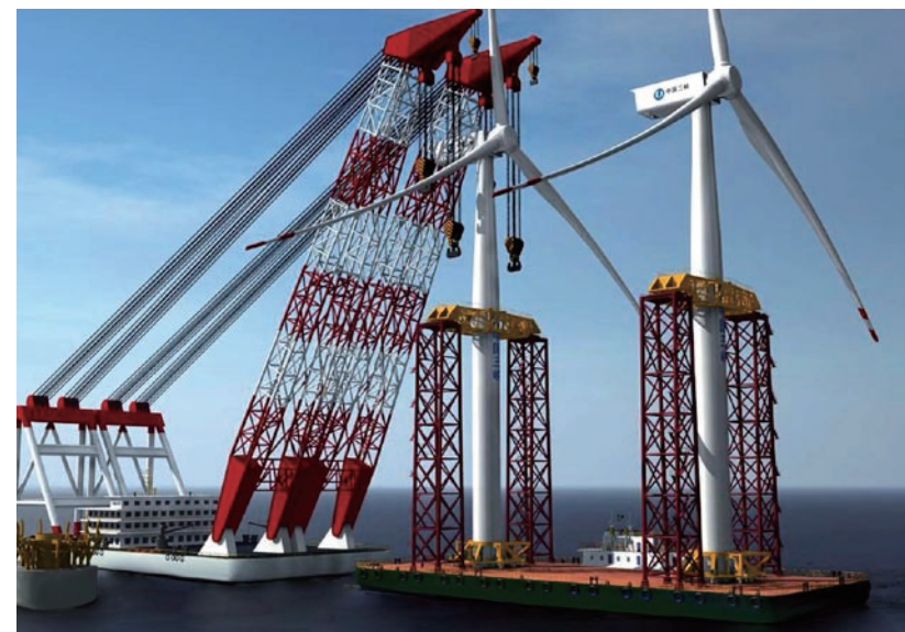
3. 整体海上运输至安装位置，起重船吊起平衡梁。
