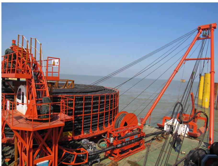
敷设中的国内首条三芯220千伏的海缆（图中黑色粗缆） 摄影/孙荣刚
