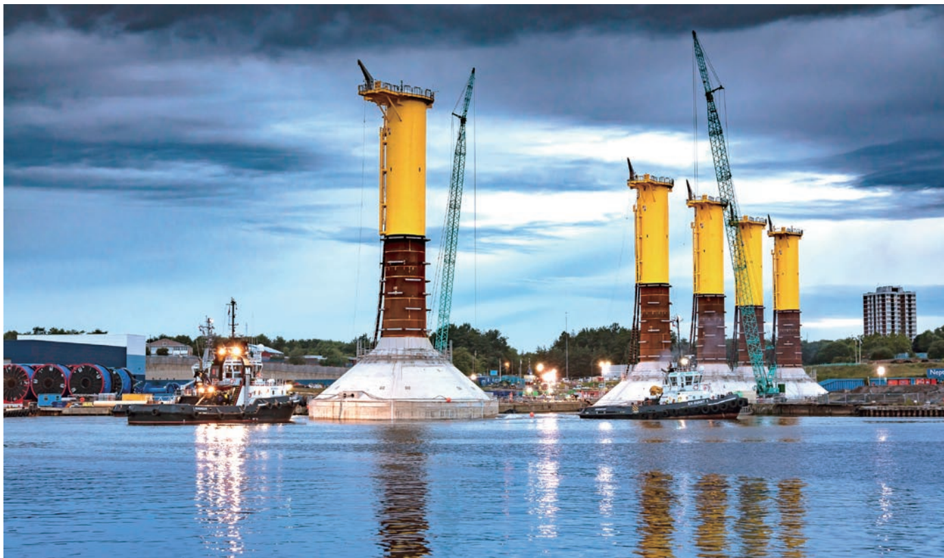
在岸边等待运输的重力式基础
