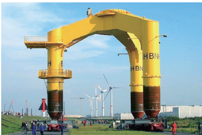
陆上运输中的三桩基础
