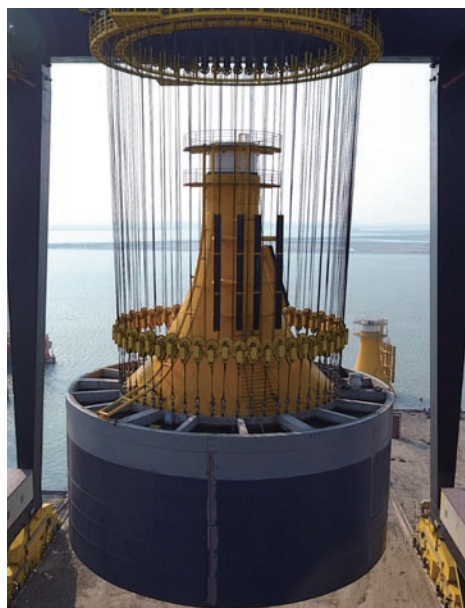
在码头起吊的负压筒式基础
