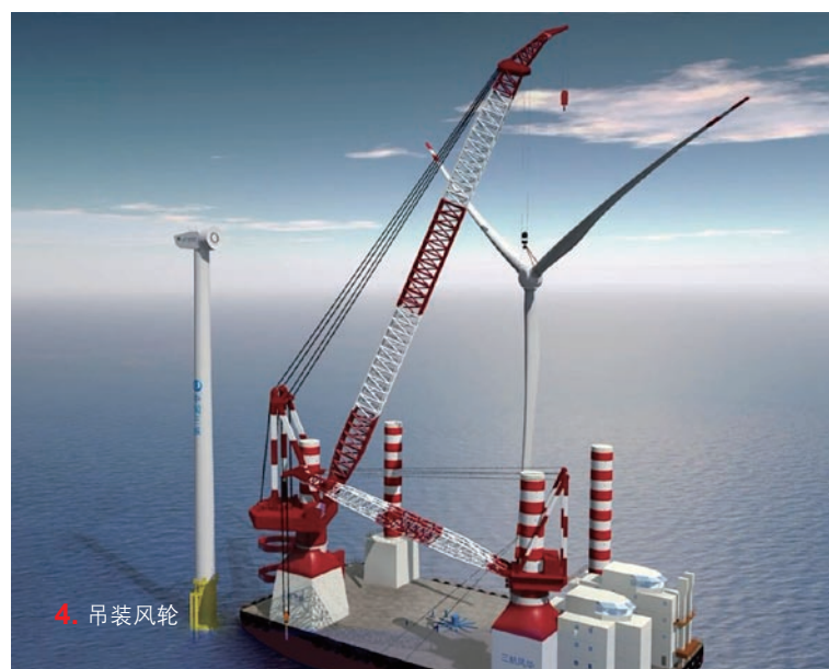
分体吊装机舱发电组件 摄影/孙荣刚
