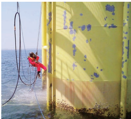
修补腐蚀位置
