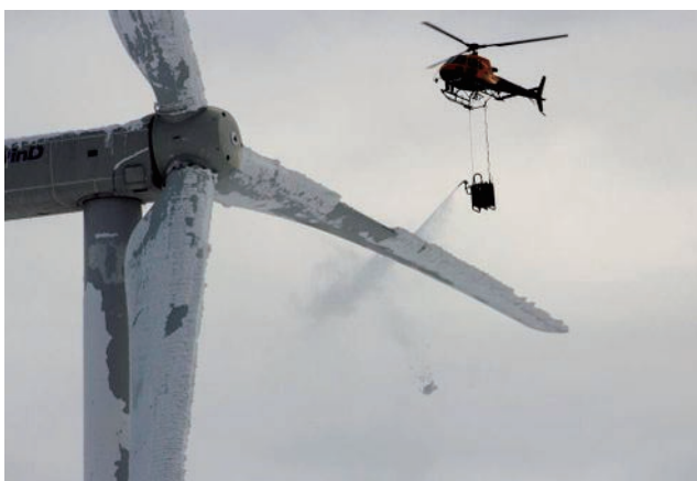
用直升机为叶片除冰
