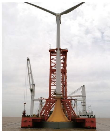
负压筒式基础与风力机一体化安装施工
