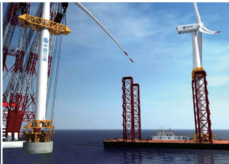
4. 吊装至基础上软着陆，缓冲软着陆装置精确定位。
