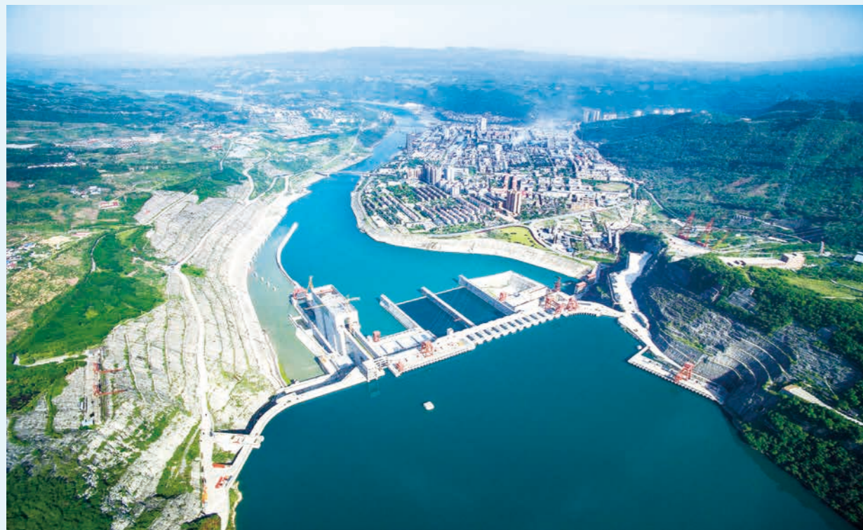
向家坝电站全景
