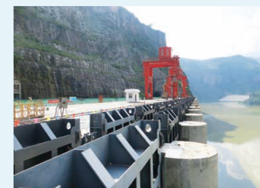
溪洛渡叠梁门分层取水
