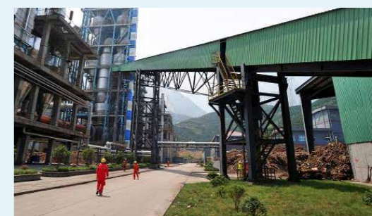
漂浮物处理进料口
