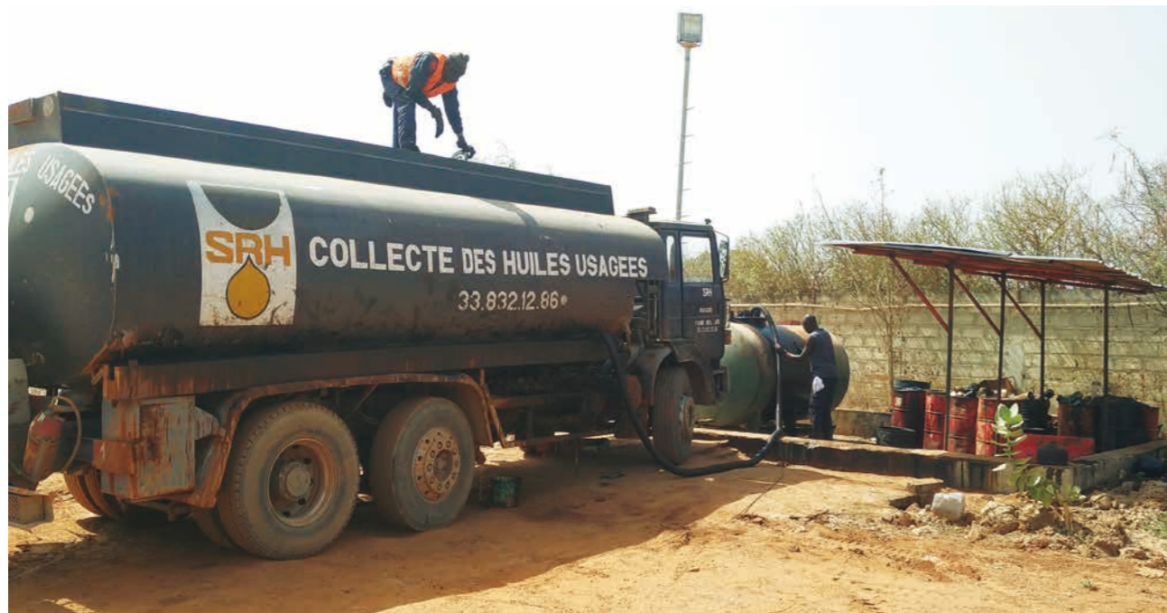
塞内加尔 AMT 高速公路项目清运废油
