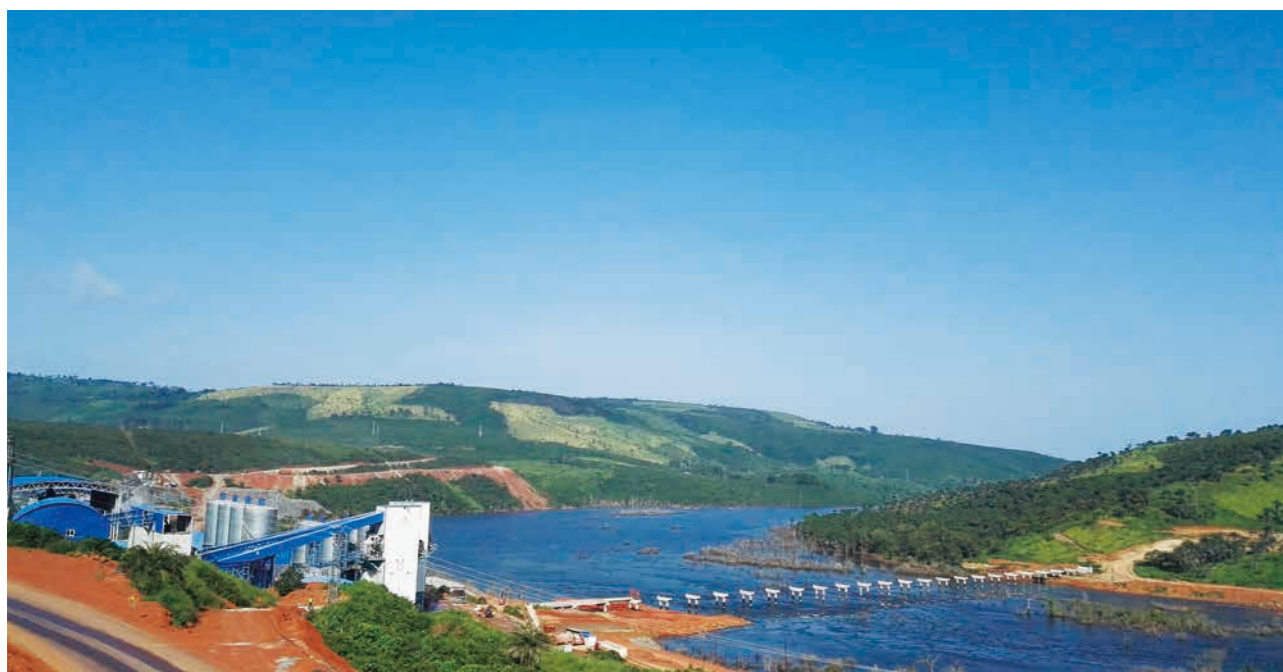
几内亚苏阿皮蒂水利枢纽项目现场一角
