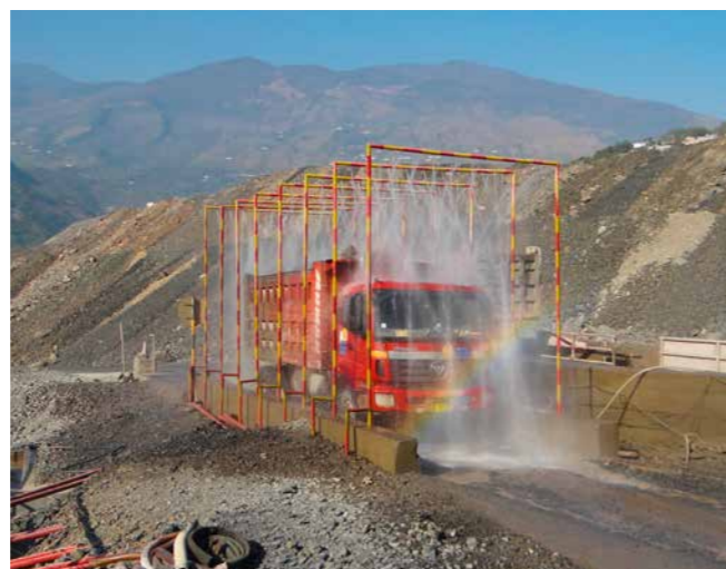
白鹤滩电站海子沟弃渣场渣车喷淋冲洗系统
